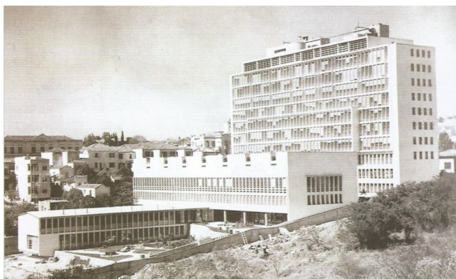
Hospital A.C. Camargo, ao final da sua construção
